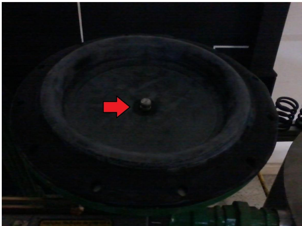
Figura 6.5 - Diafragma da válvula danificado.
