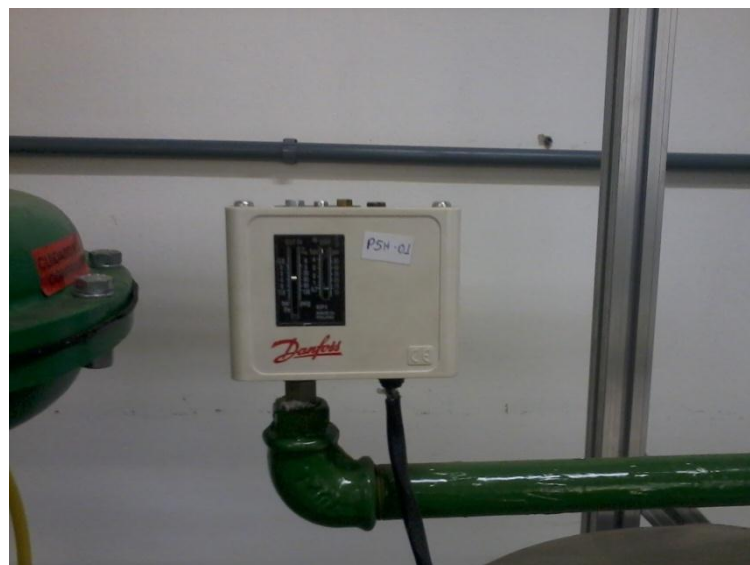
Figura 3.3 - Pressostato da planta didática.
