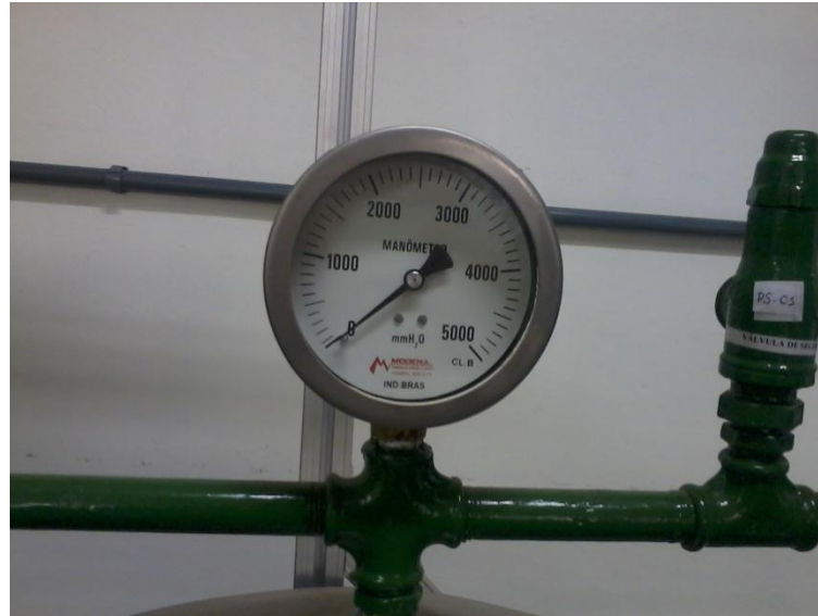
Figura 3.2 - Manômetro de Bourdon.
