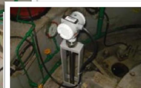
Nível de Água do Poço da Turbina de um dos Geradores da Usina Hidroelétrica.
