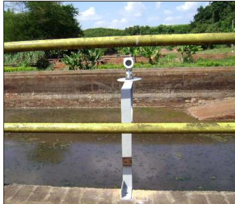
Aplicação em tanque de efluentes, da usina. Tanque subterrâneo, portanto não é possível instalar transmissores de nível do tipo do LD.
