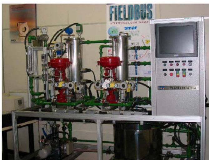
Figura 10.1 – Planta Didática Smar montada no Graco e detalhes da planta.
