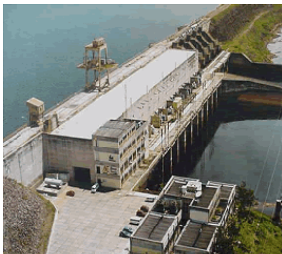
Figura 2.1 - Usina Hidroelétrica Balbina
