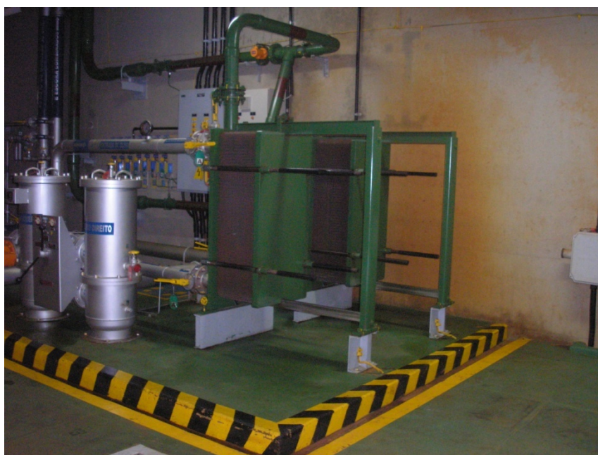
FIGURA 33: TROCADOR DE CALOR DO ÓLEO DE LUBRIFICAÇÃO DO MANCAL COMBINADO
