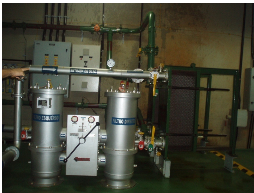
FIGURA 28: FILTROS DE ÓLEO PARA SISTEMA DE LUBRIFICAÇÃO DO MANCAL GUIA E DE ESCORA COMBINADOS. OS MEDIDORES DE PRESSÃO ESTÃO ENTRE DOIS FILTROS
