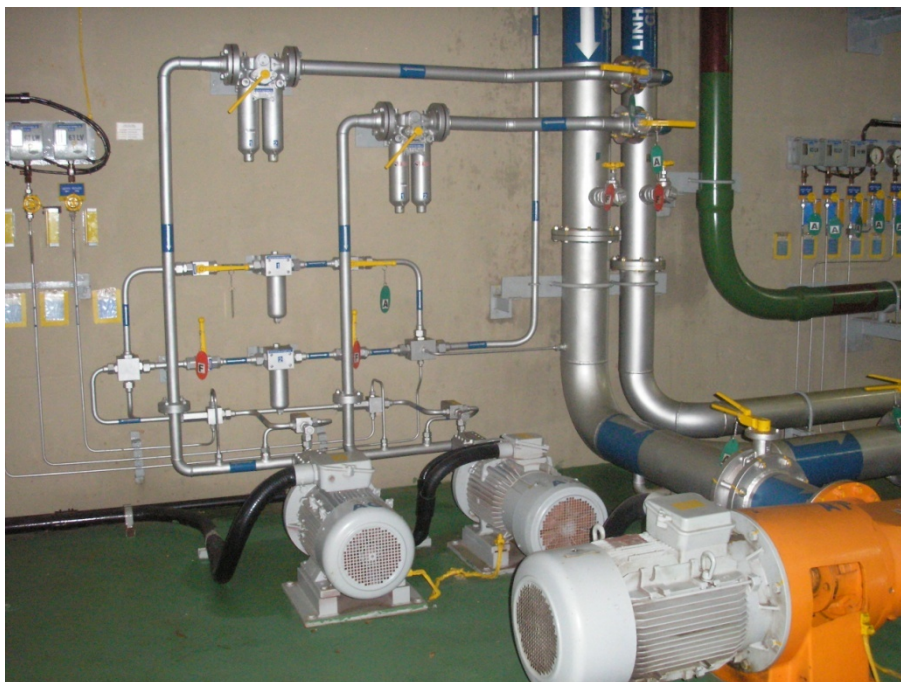
FIGURA 32: SISTEMA DE INJEÇÃO DE ÓLEO PARA CRIAR FILME DE ÓLEO NO MANCAL COMBINADO ANTES DA PARTIDA DA MÁQUINA
