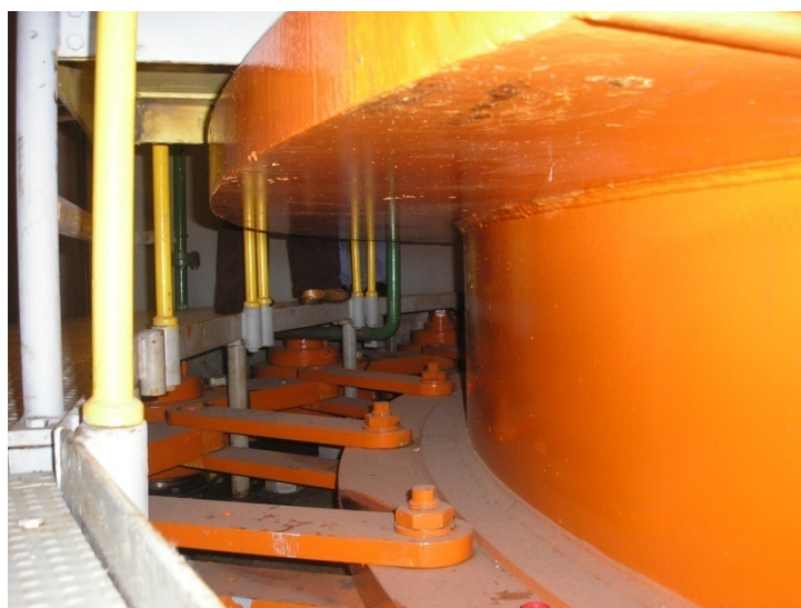
FIGURA 3: MECANISMO DE ANEL E LINKS PARA ALTERAR ÂNGULOS DAS PÁS DO HÉLICE DA TURBINA.
