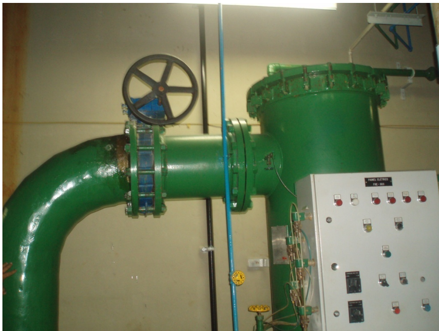
FIGURA 18: DUTO DE ENTRADA DO FILTRO DA ÁGUA CANALIZADO DA REPRESA E O FILTRO.
