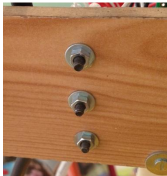
Figura 92. Montaje de los finales de carrera (paso 5). Fijación de las clemas al listón de madera
